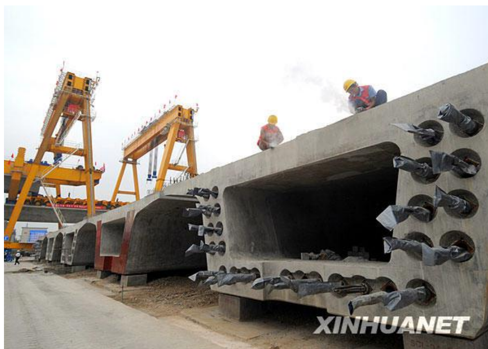
中铁十局承建的沪杭铁路客运专线第五标段成功举行了首批 900 吨箱梁的架设
